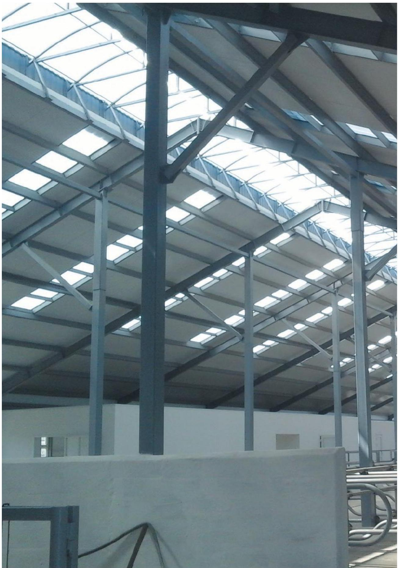
Современное решение для устройства светопрозрачных вставок в кровле. Прозрачный профлист из сотового поликарбоната итальянского производства, точно повторяющий профиль кровельной ТСП Металл Профиль и ТСП Aigranel®. Идеален для складов, производственных помещений, стадионов и помещений сельскохозяйственного назначения.
